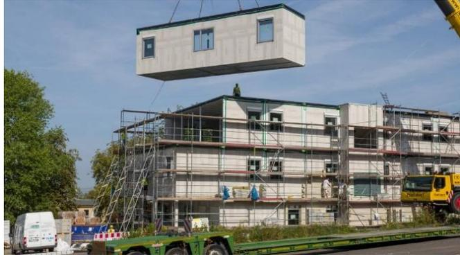
Abbildung 9: Aufsetzen eines Baumoduls
